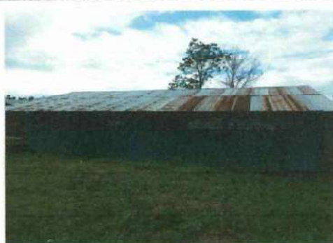
Foto 4: Cambio de techo
