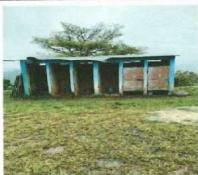
Foto 5: Cambio de puertas, cambio de láminas y pintura de paredes
