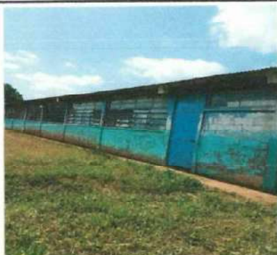
Foto 3: Pintura de paredes, reparación de ventanas cambio de vidrios
