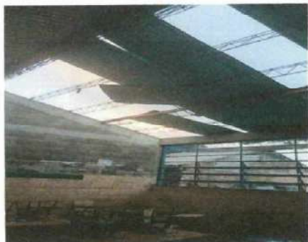
Foto1: Cambio de techo de lámina
