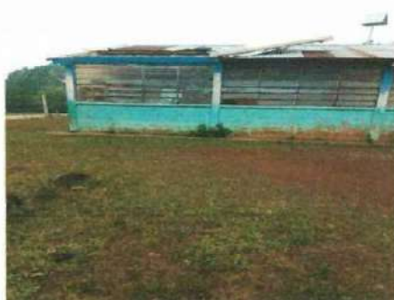
Foto 2: Cambio de techo y pintura de paredes
